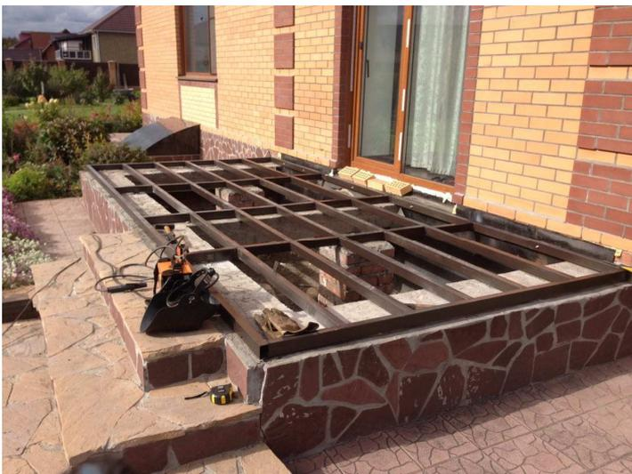
Когда бетон засох, можно приступать к монтажу несущего каркаса: по периметру сваи обваривают металлической трубой 60x40 мм со стенкой 3 мм. Затем с шагом не более 45 см приваривают тубы для создания площадки для монтажа лаг (смотрите фото). Когда вы сварили металлический каркас, его необходимо загрунтовать или окрасить, чтобы избежать коррозии.
